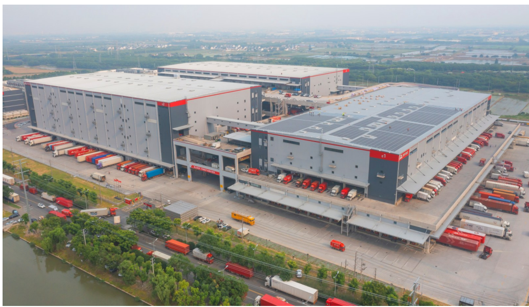
6月14日,京东物流(昆山)亚州一号智能产业园宣布完成第100亿件智能包裹的分拣,成为全球规模最大的仓拣一体智能物流园区。图为该产业园内景观鸟瞰。 人民图片
