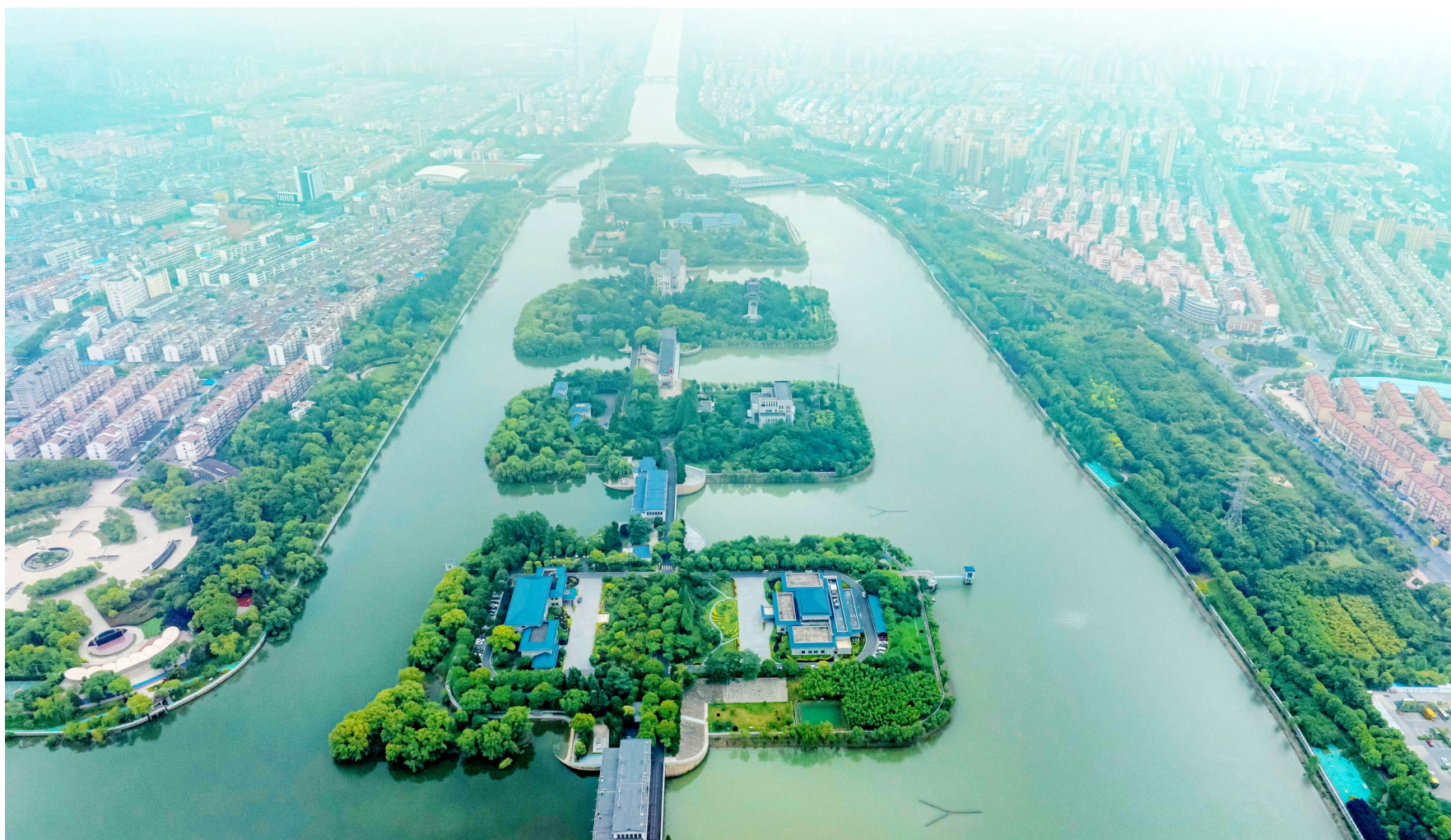
5月29日12时，江苏省南水北调工程2022—2023年度向省外调水历时139天顺利结束，完成调水11.75亿立方米，为2013年通水以来年度向省外调水之最，其中向山东省供水8.5亿立方米，向河北省、天津市北延应急调水3.25亿立方米，圆满完成了水利部确定的年度调水出省任务。图为江苏省扬州市江都区的南水北调东线源头江都水利枢纽。中新社发 任飞摄
