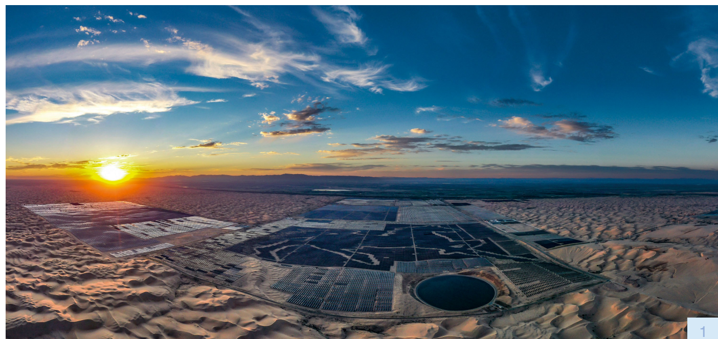
1. 航拍鄂尔多斯市达拉特旗光伏基地。人民图片
