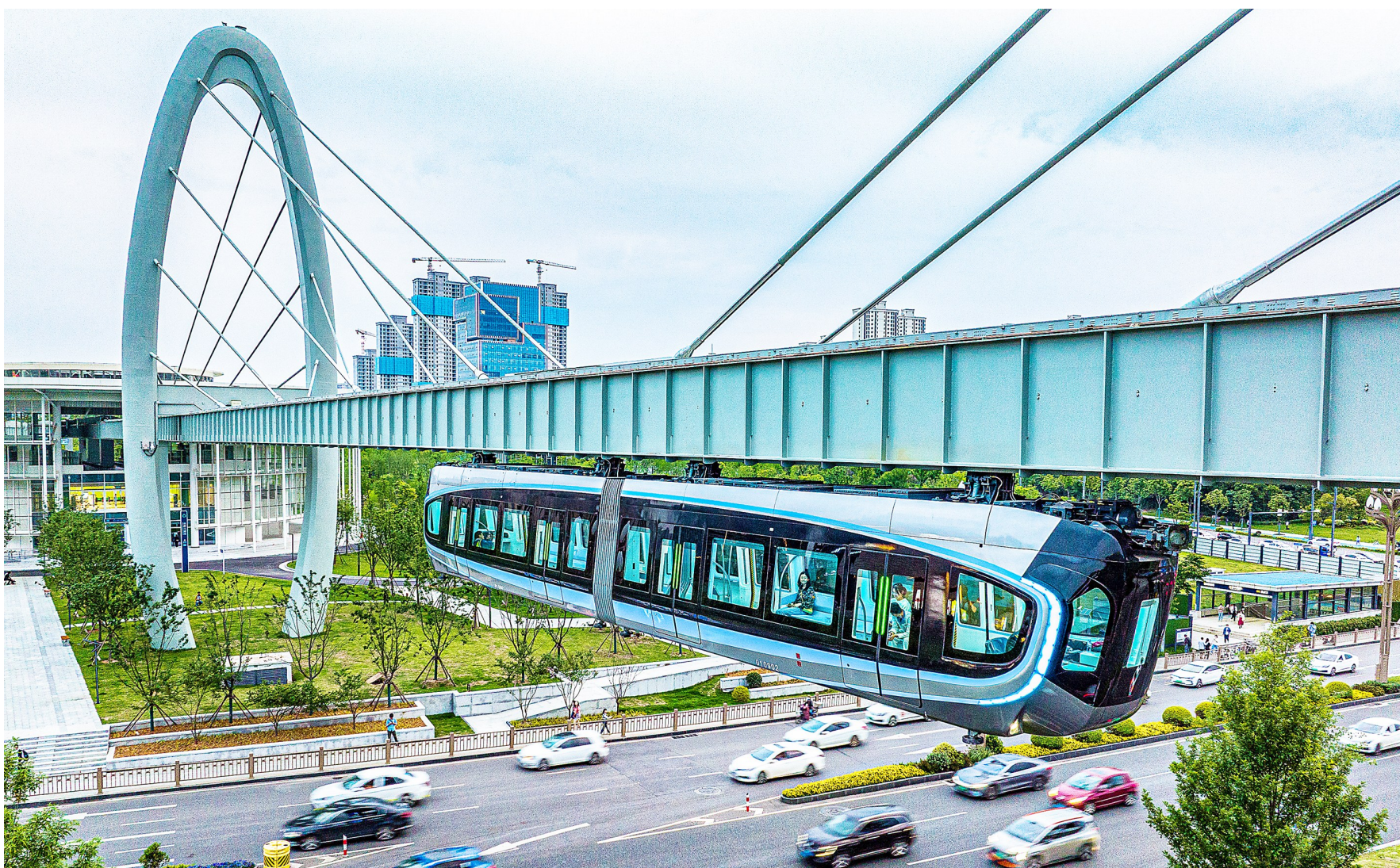
列车悬挂在轨道下方，从人们头顶飞驰而过，这样的科幻场景最近在湖北省武汉市东湖新技术开发区成了现实。目前，光谷空轨正处于综合联调和试运行阶段，进展顺利。空轨全称为悬挂式单轨列车，是一种新型中低运量轨道交通制式，具有不占用地面路权、环境适应性强等优点，兼具通勤和观光功能。 新华社记者 肖艺九摄
