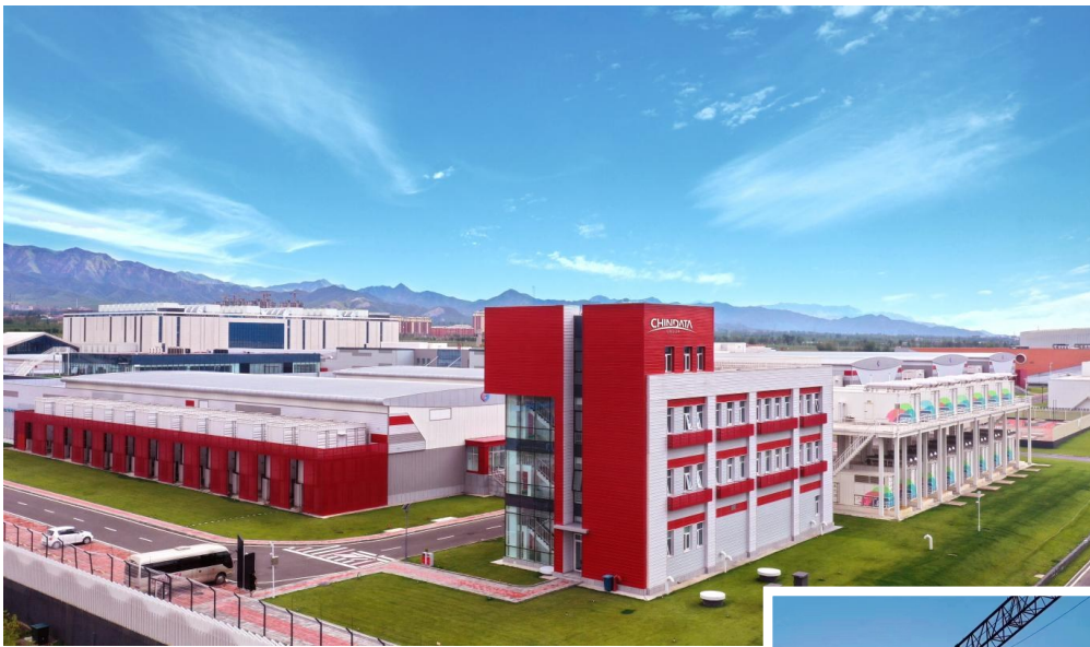
怀来大数据产业基地秦淮数据集团外景。
