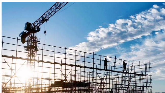
怀来大数据产业基地内，合盈数据科技产业园的工人们正在紧张施工。
