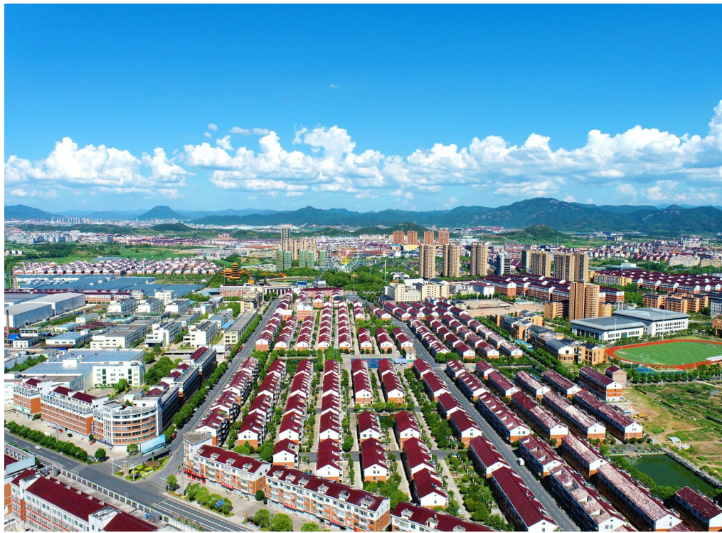
东阳市花园村俯瞰图。花园村供图
