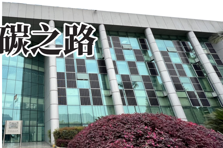
在重庆市南岸区一家水机中央空调生产基地内，工厂办公楼外立面上的光伏板把太阳光转化为工业园区的绿色电力。
