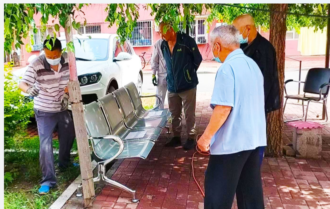
吉林市龙潭区龙华街道“共享物业社”工作人员为小区居民安装休闲座椅。
