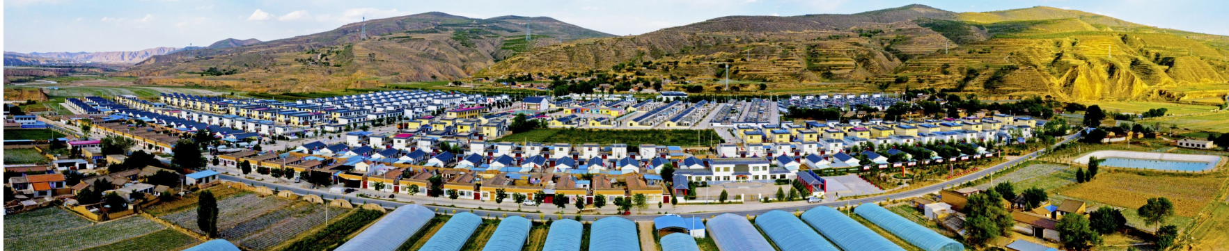
甘肃省定西市安定区鲁家沟镇将台村安置点全景图。
