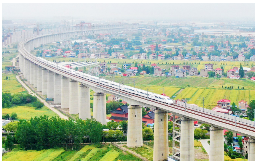
沪苏通长江公铁大桥于2020年7月1日开通运营，是沪苏通铁路的关键控制性工程。图为列车在沪苏通长江公铁大桥上飞驰。
