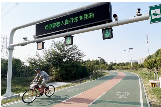
国内首条通勤用自行车专用路——北京昌平回龙观至海淀上地软件园自行车专用路。
