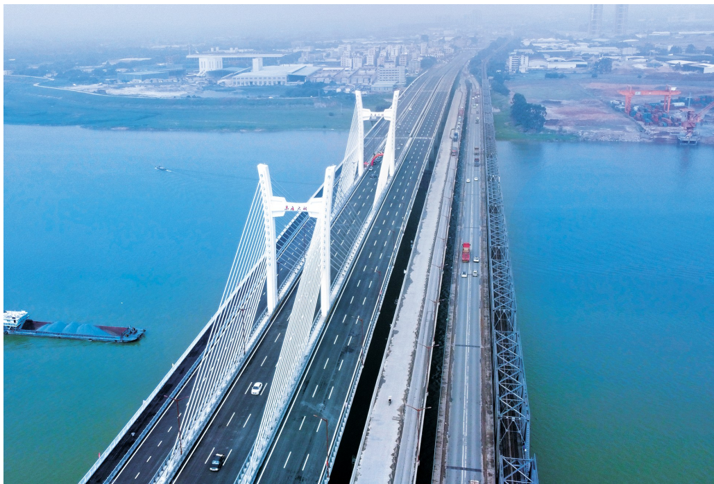
近期,由中铁一局承建的粤港澳大湾区马房特大桥建成通车。该桥全长1639米,跨越珠江水系干流之一的北江,主路双向六车道,设计时速80公里。作为连接广东省肇庆市和佛山市的重要交通基础设施,该桥的建成通车将有助于加快粤港澳大湾区城市互联互通、融合升级。
