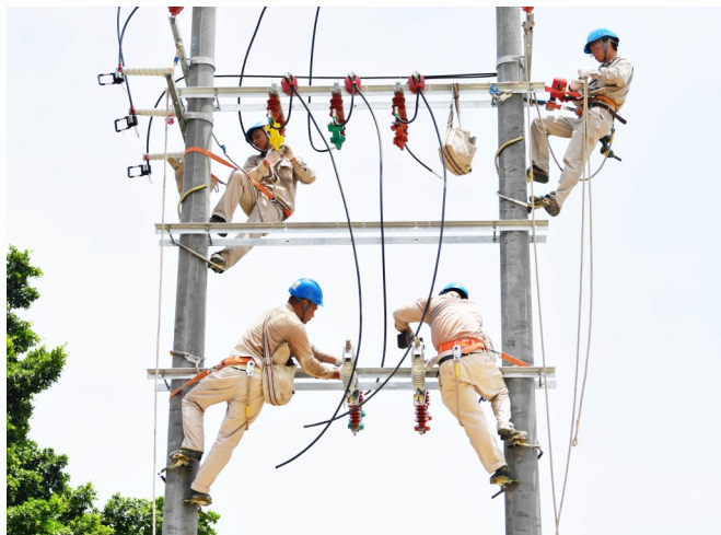
国网福建电力“双满意”(泉州海丝之光)共产党员服务队队员为晋江地区企业更换老旧变压器。
