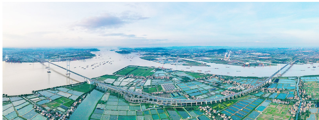
在建的深中通道、黄茅海跨海通道和已经运营的港珠澳大桥、南沙大桥、虎门大桥等,一起构建粤港澳大湾区跨海跨江通道群。这些大湾区“硬联通”工程为湾区人员、物流以及创新技术等流通发挥重要作用。图为南沙大桥全景。
