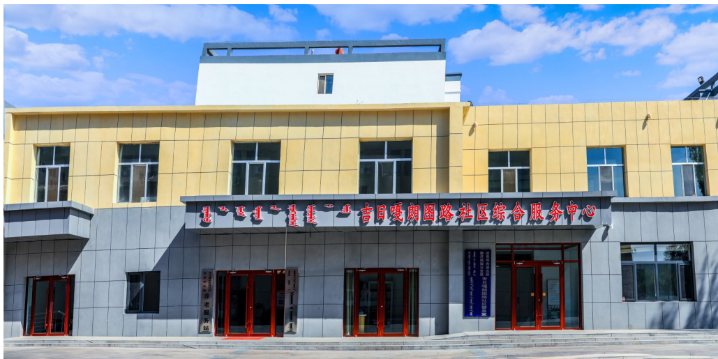
阿拉善盟额济纳旗达来呼布镇团结小区利用原废弃库房改造、新建社区综合服务中心。
