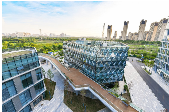
长三角G60科创走廊金融科技产业合作示范园区——合肥金融广场一期建成后,吸引了多家企业与机构入驻。该项目是安徽省合肥市重点建设的金融生态集聚区,打造金融全产业链的长三角金融副中心,其功能组团包括金融产业、金融生态、科技创新、配套商业等。图为合肥市金融广场的主入口建筑楼宇。
