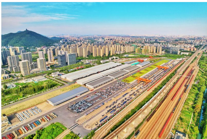
暑运是货物运输繁忙的时期。长三角铁路持续开展货运大会战攻坚战,全力落实保通保畅措施,打通运输堵点,加大运能供给,畅通多式联运渠道,保障产业链供应链的稳定。图为浙江省杭州货运中心杭州北铁路一级物流基地。
