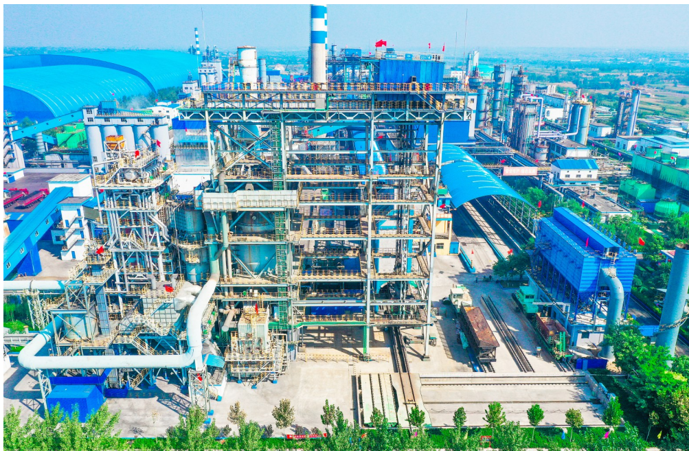
在位于临汾的山西光大焦化气源有限公司厂区内，红焦进入干熄焦装置被惰性气体熄灭，释放的热量经汽轮机发电把热能变成电能商品。 山西光大焦化气源有限公司供图
