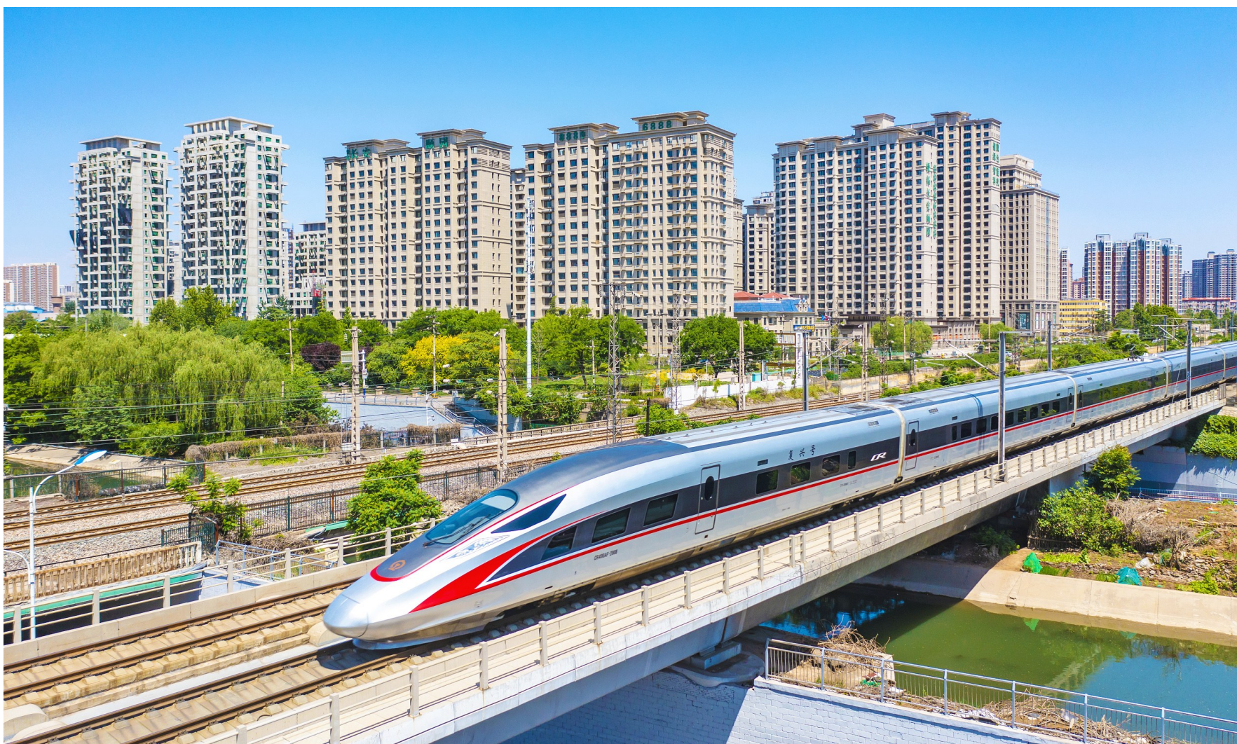
5月13日,京广高铁建设安全标准示范线取得重大成果,京武段拉通试验圆满成功。预计6月20日起北京至武汉间将率先常态化按时速350公里高标运营,北京至武汉间最短运行时间压缩至3小时48分,旅客出行体验进一步提升。图为5月13日,试验列车行驶在京广高铁石家庄区段。视觉中国
