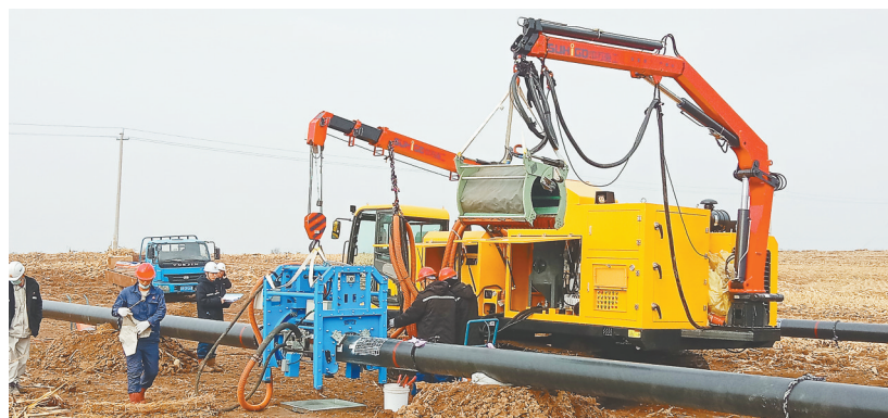
工作人员对梅桦线天然气管道进行防腐喷砂作业。王 娇摄
