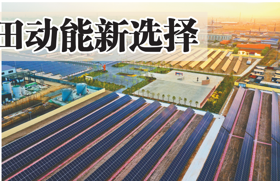
中国石化胜利油田在功勋井——营二井区域实施的风光热储多能互补综合利用项目。
