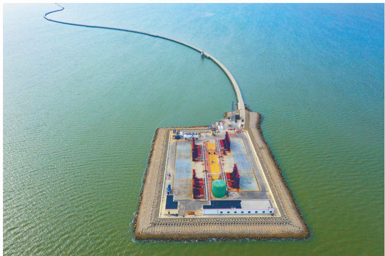
胜利油田自动化和信息化程度最高的海油陆采平台——青东5滩海陆岸采油平台。
