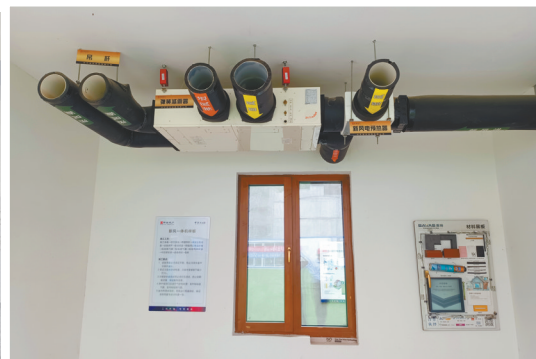
▲中海河山大观项目新风一体机管路构成图。
