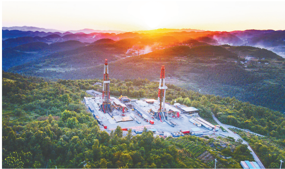
图为石化油服在焦页11平台东加密井钻井施工现场。中国石化供图
