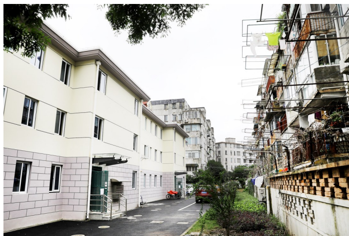
从“大拆大建”到“留改拆”并举,上海市杨浦区武川路222弄小区拆除重建的实践,为上海城市更新的推进工作提供了一则成功案例。图为杨浦区武川路222弄小区内原址拆除重建的新居民楼。新华社记者 方喆摄
