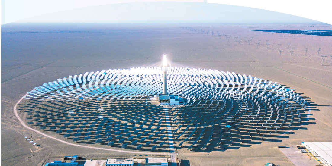
位于敦煌市的百兆瓦熔盐塔式光热发电站。酒泉市委宣传部供图
