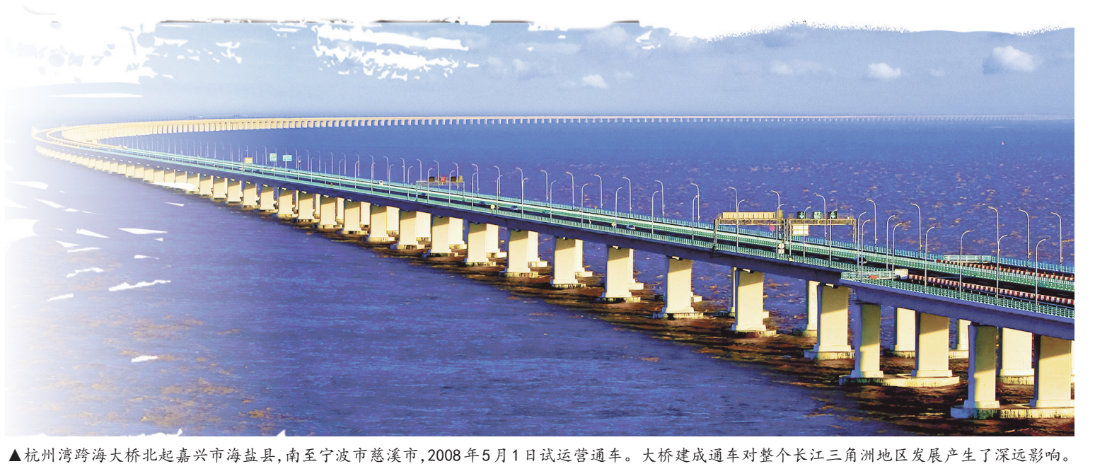
▲杭州湾跨海大桥北起嘉兴市海盐县，南至宁波市慈溪市，2008年5月1日试运营通车。大桥建成通车对整个长江三角洲地区发展产生了深远影响。
