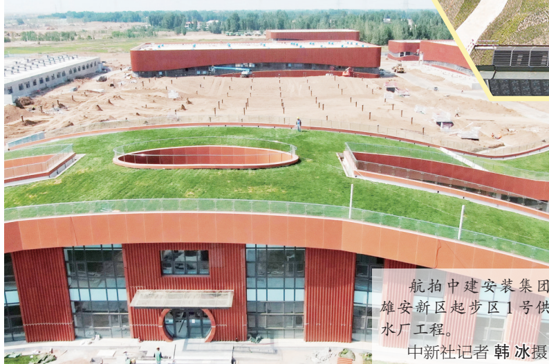
航拍中建安装集团雄安新区起步区1号供水厂工程。中新社记者 韩冰摄
