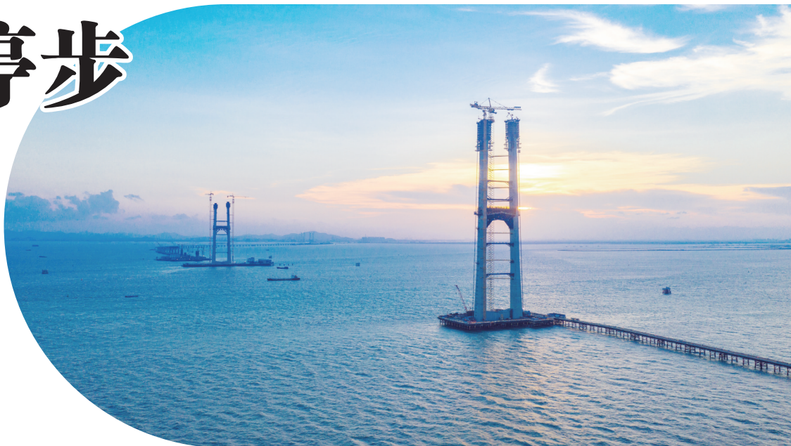
建设中的深圳市深中通道伶仃洋大桥。人民图片
