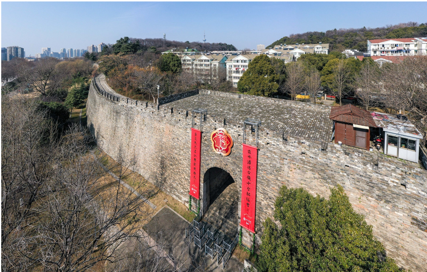
近日，江苏省南京市明城墙中华门、玄武门、解放门等12座城门陆续挂上巨幅春联，迎接春节的来临。据介绍，这些悬挂在城门上的春联最高的约15米、宽约2米，均采用不伤害城墙本体的方法悬挂。图为2月4日拍摄的清凉门。 新华社记者 李博摄
