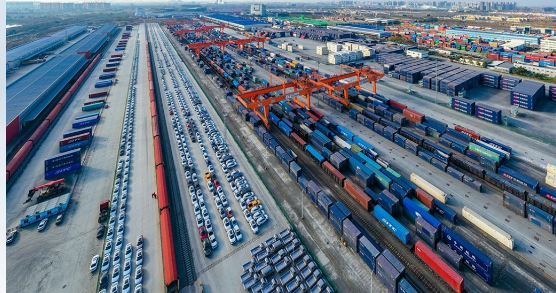
繁忙的成都铁路集装箱中心站航拍图。
