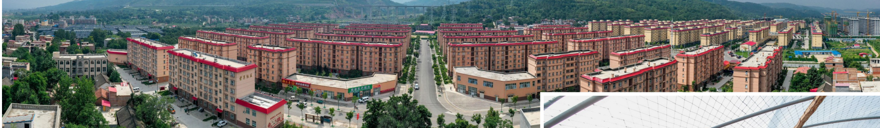
卢氏县兴贤里易地扶贫搬迁安置社区，是河南省目前最大的易地扶贫搬迁安置社区。 聂金锋摄
