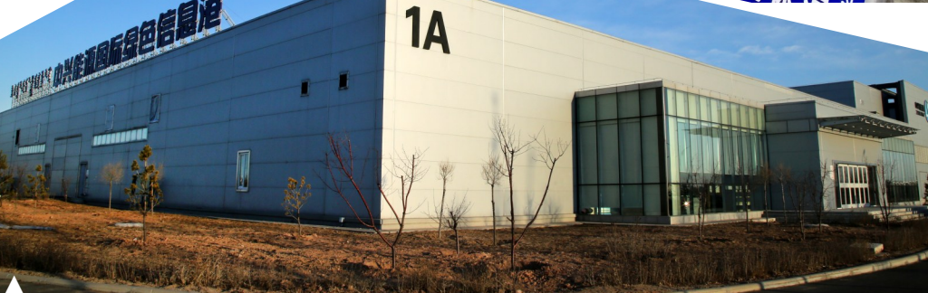
鄂尔多斯市高新技术产业园区云计算产业园云泰互联绿色数据中心。
