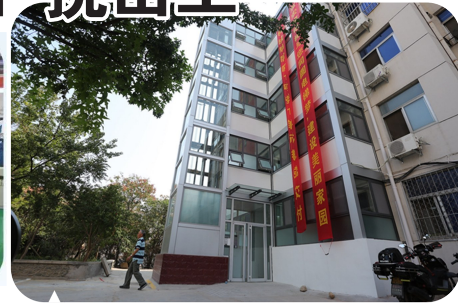
2019年9月26日，泰安市首部投入使用的既有住宅增设电梯交付。陈阳摄
