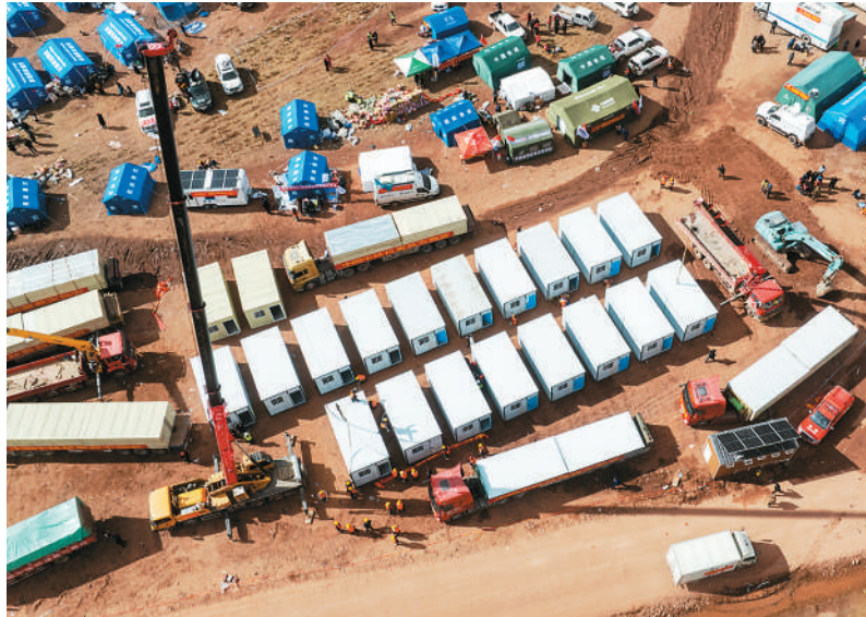
10月24日，由中国中铁集团负责搭建的第一批安置板房在受灾核心区西藏自治区巴青县玛如乡扎若改村搭建完成。图为中国中铁集团的工作人员在巴青县玛如乡扎若改村搭建板房。 新华社记者 丁增尼达摄
