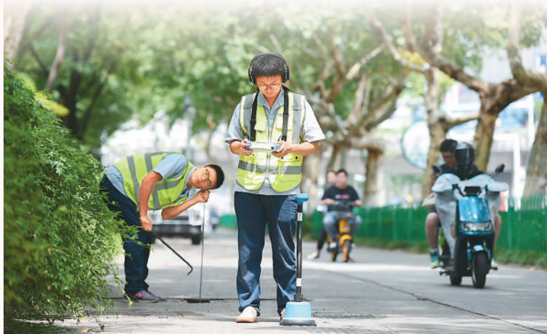
▲安徽合肥供水集团工作人员在合肥市芜湖路进行常态化巡检。 新华社记者 黄博涵摄
