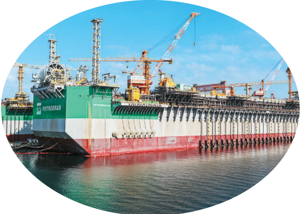
▲由中集集团为巴西国家石油公司建造的大型浮式生产储卸油装置P-84船体在山东烟台完工。 唐 克 摄（人民视觉）
