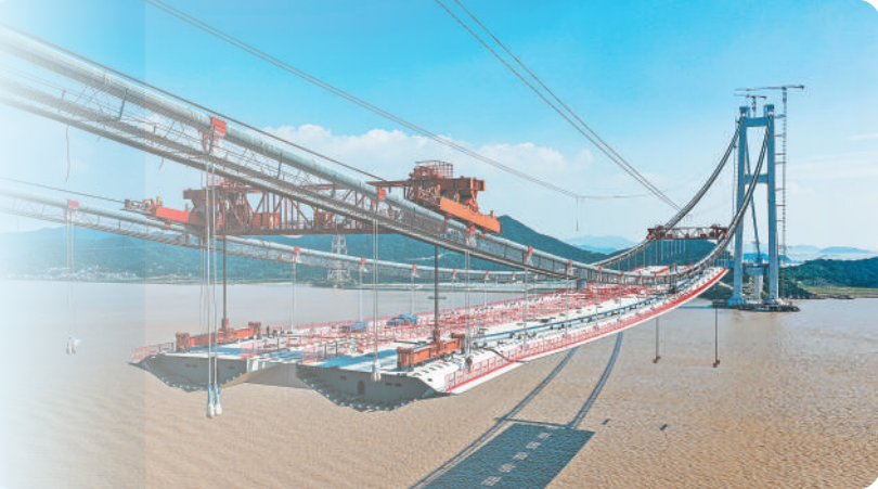
▲由中国铁建大桥局承建的宁波舟山港六横公路大桥二期工程双屿门特大桥架梁现场。姚 峰 摄（人民视觉）
