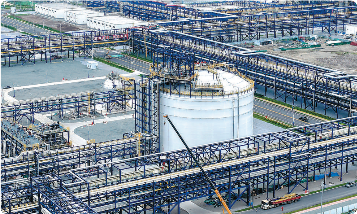
▲位于江苏南通通州湾示范区的中国石油蓝海新材料高端聚烯烃项目建设全速推进，现场忙碌有序。 许丛军 摄（人民视觉）
