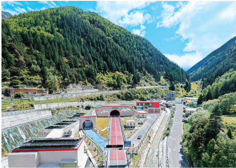
四川夹金山隧道。
