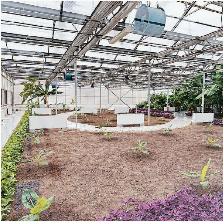
位于建三江国家农业科技园区的智能温室。
