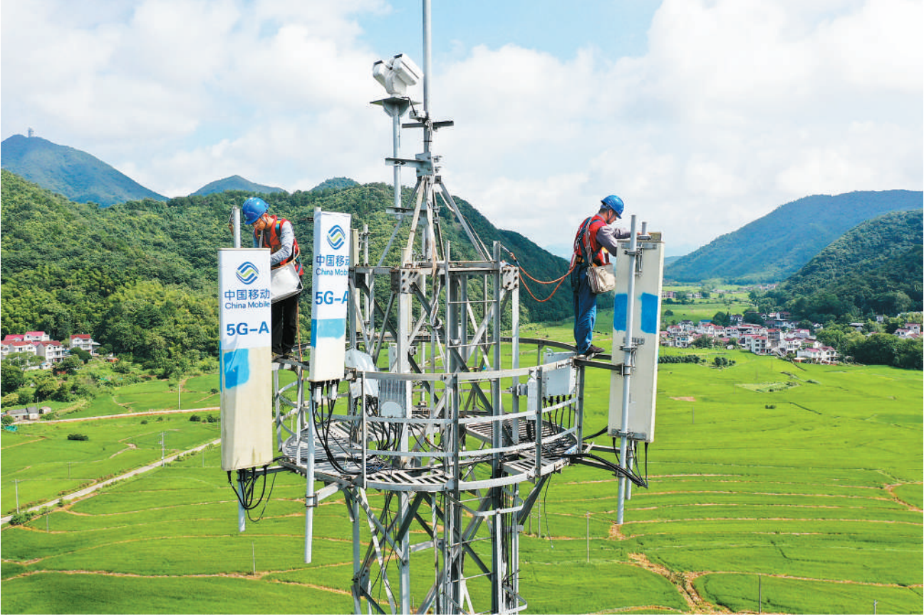
中国移动铜陵分公司技术人员在安徽省铜陵市义安区钟鸣镇泉栏村通信塔上调试设备、升级5G-A网络。过仕宁摄（人民视觉）
