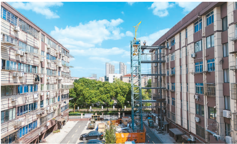
近年来，江苏省南通市通州区加快推进城区老旧小区适老化改造民生工程，切实提升群众获得感、幸福感。图为通州区金新街道，工人在进行加装电梯施工作业。
