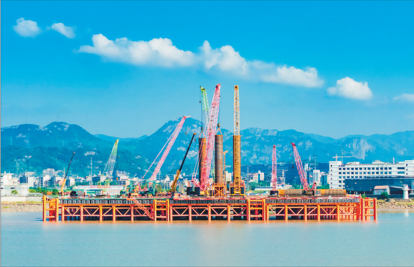
9月18日，位于浙江省温州市的温福高铁瓯江公铁大桥建设现场，桩基钢护筒吊装作业正在进行。目前32号主墩桩基钢护筒已安装过半，施工人員正加紧施工，项目建设正酣。
