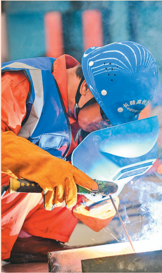
▲ 中国铁建大桥工程局集团有限公司长赣高铁站前10标项目部举行的技能比武大赛中，选手在进行焊接技能比拼。 胡江涛摄（人民视觉）
