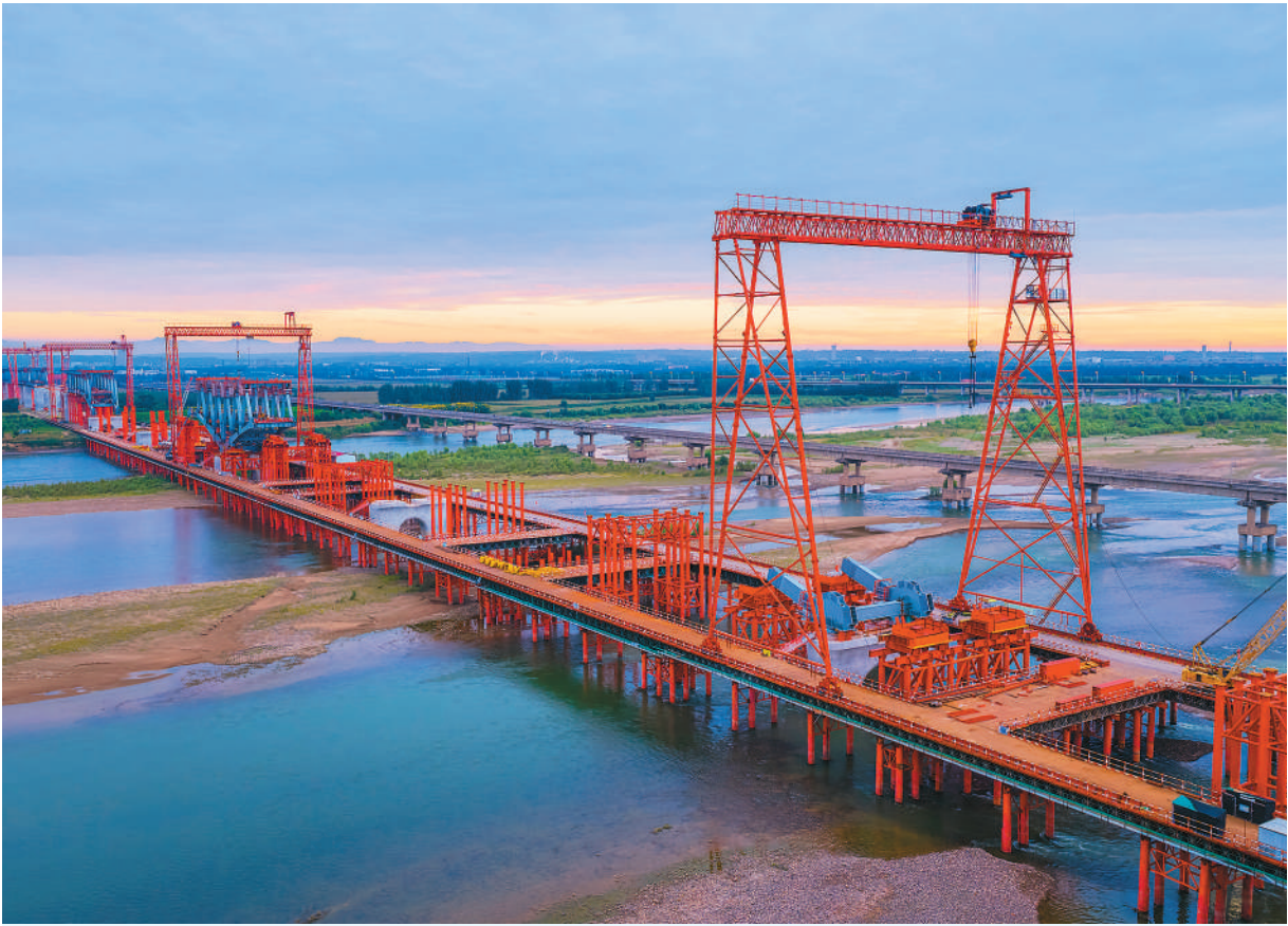
眼下，呼南高铁（内蒙古自治区呼和浩特市至广西壮族自治区南宁市）洛阳黄河公铁大桥正在加紧施工。该大桥是呼南高铁焦洛平段控制性工程，目前大桥主跨钢桁梁架设全面展开，标志着桥梁主体建设进入攻坚期。图为大桥施工现场。
