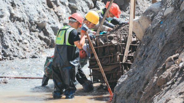
当前，吉隆泥石流受灾核心区抢险救援工作持续推进。图为9月5日，在吉隆泥石流受灾核心区，施工人员装填石块加固道路。
