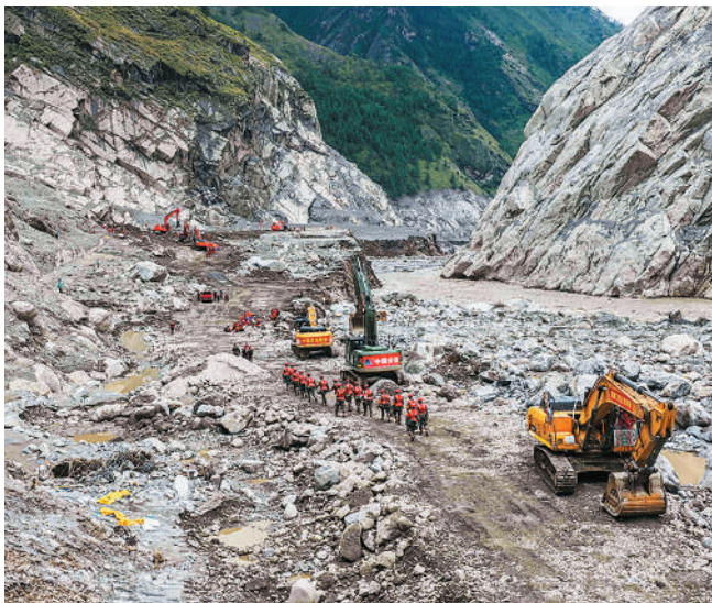
9月2日，武警西藏总队日喀则支队官兵挺进救援现场。
