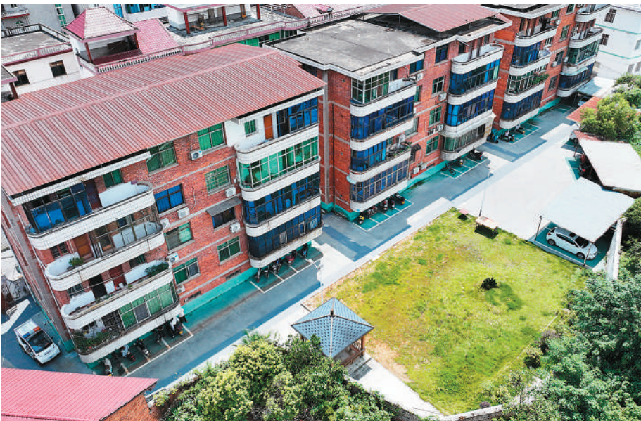
萍乡市莲花县实施老旧小区片区排水防涝提质项目，改造后的城南社区路面干净整洁，群众居住舒适度得到提升。冯志华摄
