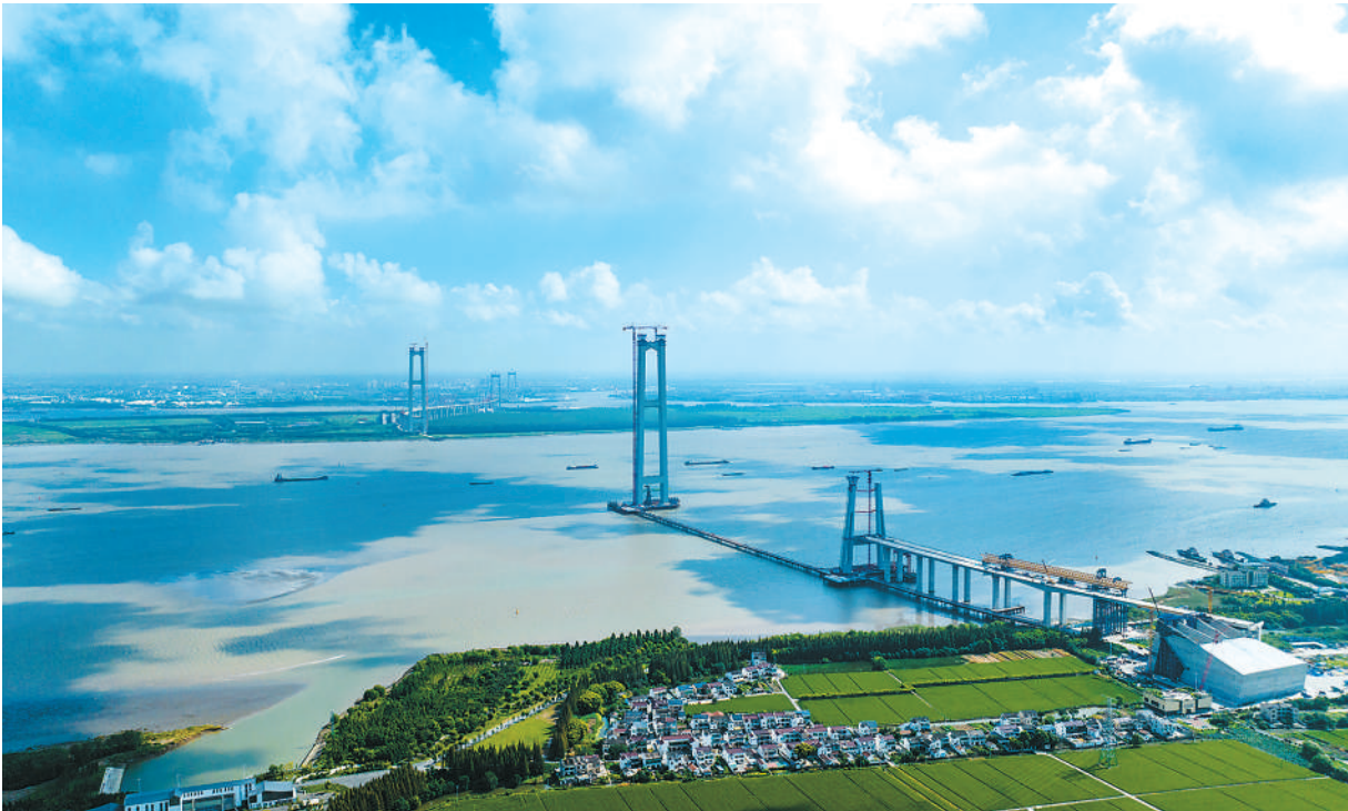
日前，由中交二航局承建的江苏张靖皋长江大桥南航道桥南锚碇主体结构顺利完工，为后续主缆架设及钢箱梁吊装奠定了坚实基础。 张靖皋长江大桥是世界上在建的最大跨度桥
