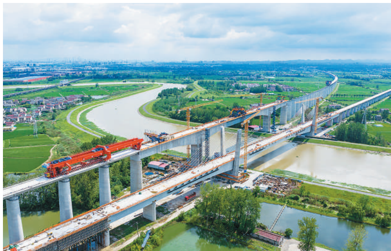
近来,上海至南京至合肥高铁(沪宁合高铁)六合特大桥跨滁河主桥项目现场,施工人员加快推进工程建设。沪宁合高铁为国家“八纵八横”高速铁路网沿江通道的重要组成部分,对于打造“轨道上的长三角”、优化区域铁路网布局具有重要意义。图为该项目施工现场。
