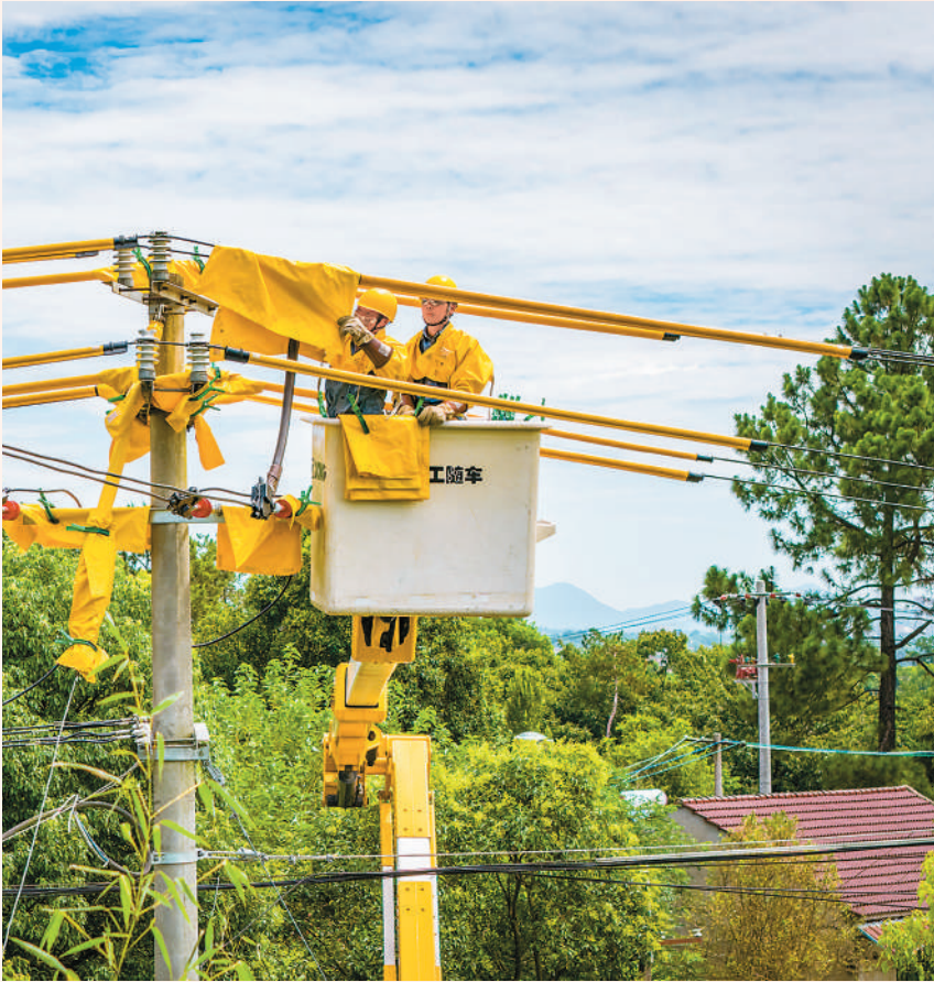
▼近日，安徽省庐江县高温导致用电负荷持续攀升，国网庐江县供电公司按期完成14项主配网迎峰度夏重点工程类措施，有效补强电网网架。图为国网庐江县供电公司工作人员在罗河镇10千伏罗河线金龙支线冒着高温开展带电接火作业。 李梁缘摄（人民视觉）
