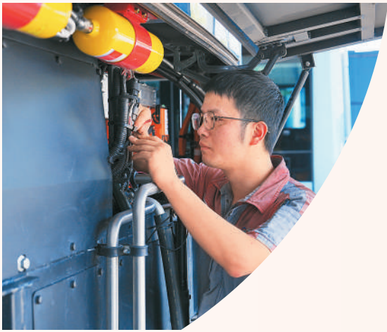
▲在重庆交通开投集团公交北部分公司维修厂七一桥厂区，被称为“公交医生”的维修工人采取错峰作业，保障上千台公交车辆稳定运行，守护乘客出行安全。图为一名工人在对公交客运车辆进行维保。 秦廷富摄（人民视觉）
