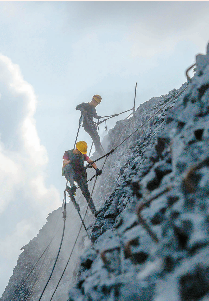
▲湖南省永州市道县，工人在零（陵）道（县）高速公路施工现场作业。针对持续高温酷暑天气，零道高速公路项目建设单位推行弹性施工制度，避开午间高温时段，保障工人安全。 蒋克青摄（人民视觉）
