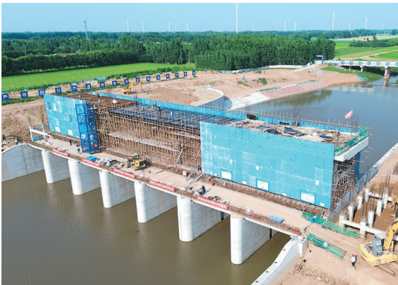
在河南省许昌市鄢陵县彭店镇,赵口引黄灌区现代化改造工程加紧施工。 牛书培摄(人民视觉)
