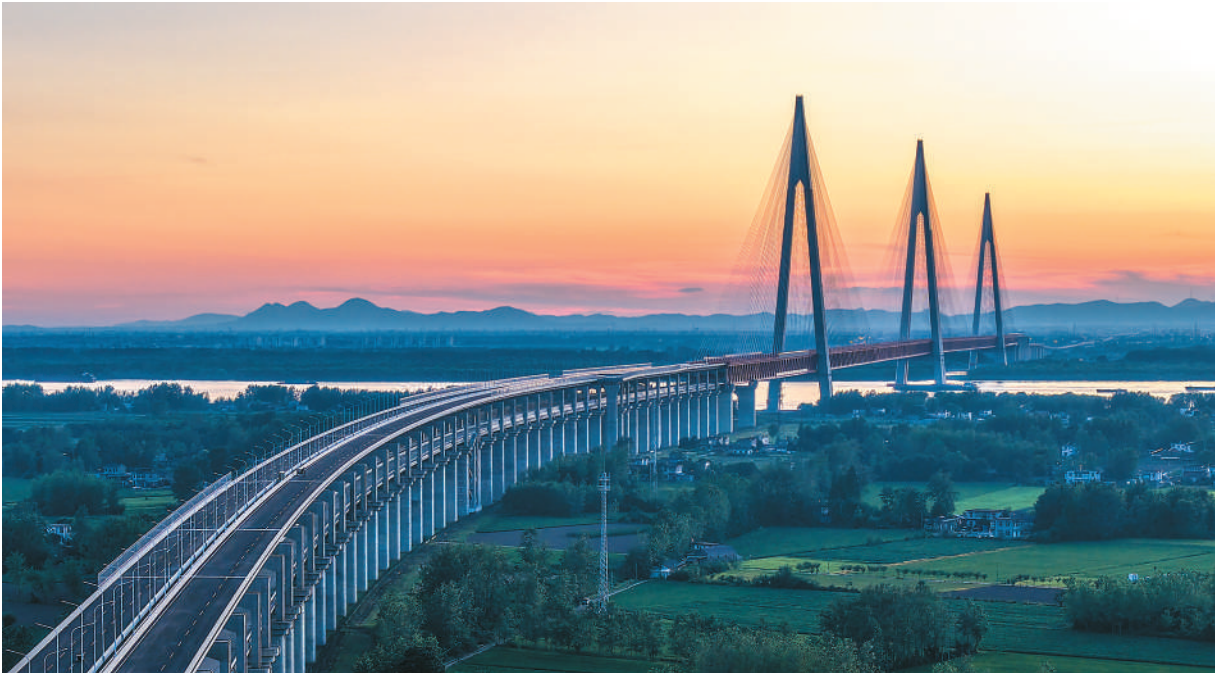
马鞍山长江公铁大桥连接安徽省马鞍山市和县当涂县，是巢马高铁全线控制性工程。项目建设推进顺利，力争今年9月具备通车条件。建成通车后，对深入推进长三角一体化发展具有重要意义。 图为马鞍山长江公铁大桥。
