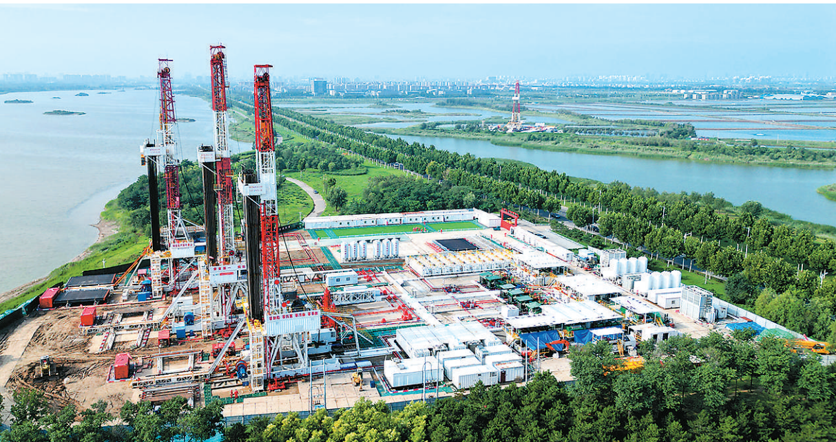
7月28日，山东省东营市，胜利济阳页岩油国家级示范区一页岩油井工厂在开展页岩油气资源勘探开发。这是国内首个陆相断陷湖盆页岩油国家级示范区，累计新增探明储量3.27亿吨，关键技术打破国外行业垄断，为我国陆相断陷盆地页岩油大规模勘探开发提供了宝贵经验。刘智峰摄（人民视觉）
